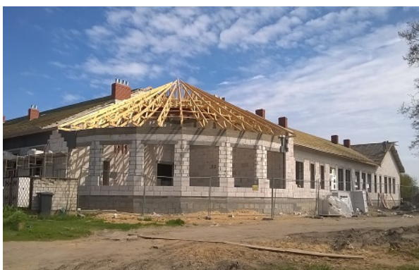
Nowe przedszkole w trakcie budowy
