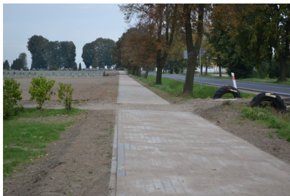
Budowa chodnika w Ciachcinie
