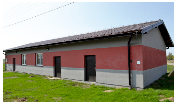
Wyremontowana świetlica w Tłubicach
