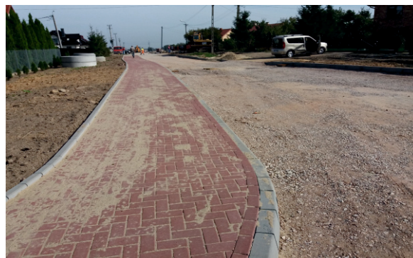
Budowa osiedla w Bielsku
