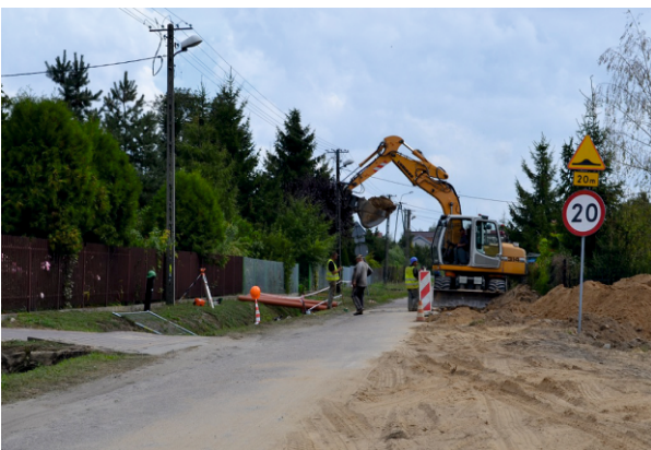
Budowa sieci kanalizacji sanitarnej Zagoty - Cekanowo - Bielsk
