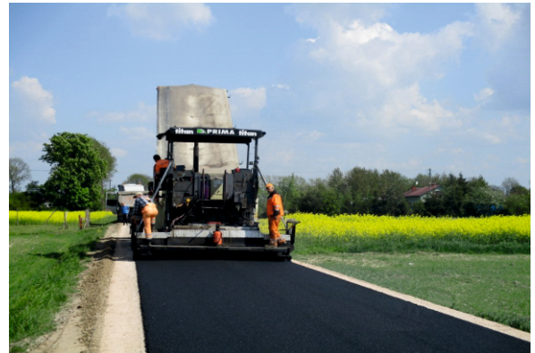
Remont drogi gminnej
