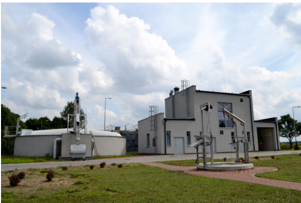
Nowa oczyszczalnia ścieków w Bielsku
