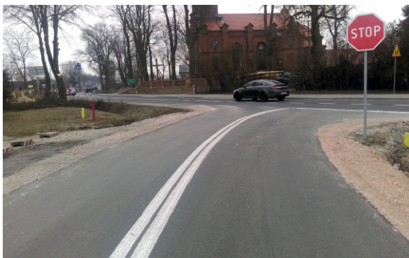
Droga gminna po przebudowie
