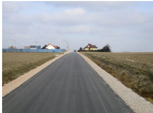
Droga gminna po przebudowie
