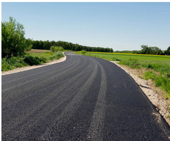
Efekt projektu: „Przebudowa drogi gminnej Umienino – Pęszyno”
