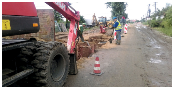
Praca nad budową sieci kanalizacyjnej
