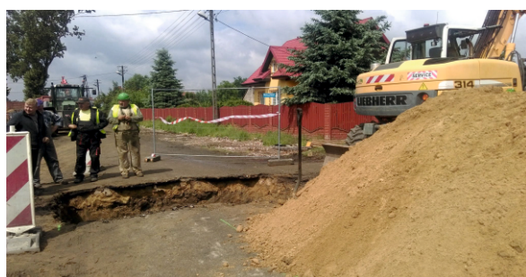
Budowa sieci kanalizacyjnej
