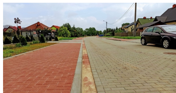
Zrealizowany I etap inwestycji
