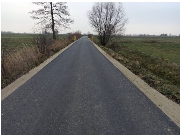
Nawierzchnia asfaltowa w Dębsku
