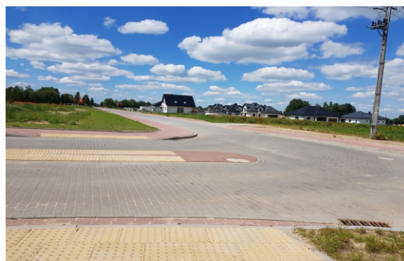
Zrealizowany I etap inwestycji
