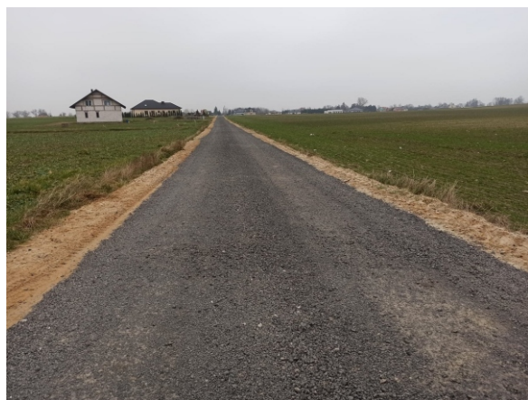
Zmodernizowana nawierzchnia w Niszczycach
