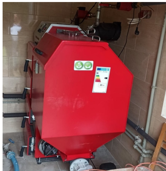
Remont C.O. w świetlicy w Rudowie
