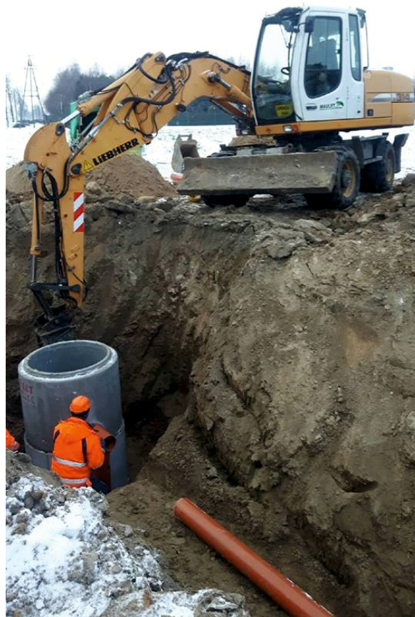
Prace podczas budowy kanalizacji sanitarnej
