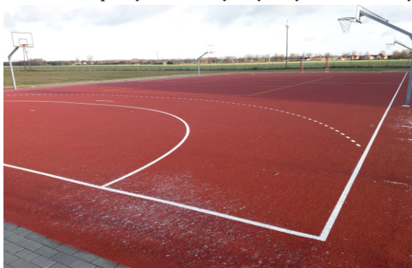
Wyremontowane boisko w Bielsku
