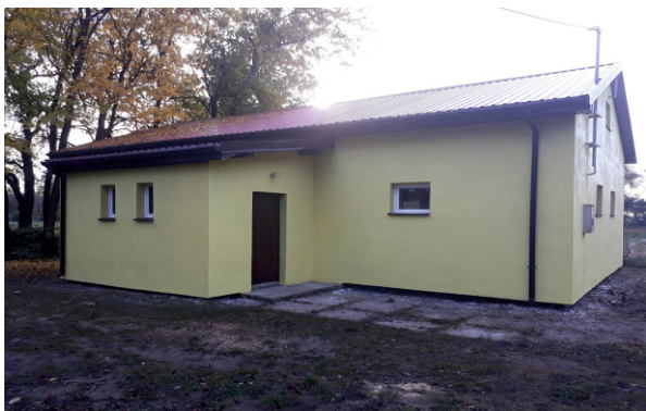
Wyremontowana Świetlica w Machcinie
