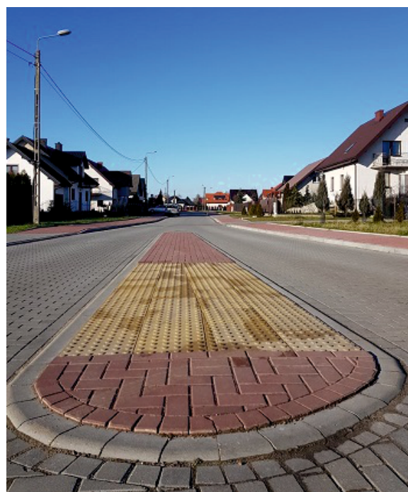
Przebudowa ulic osiedlowych w Bielsku
